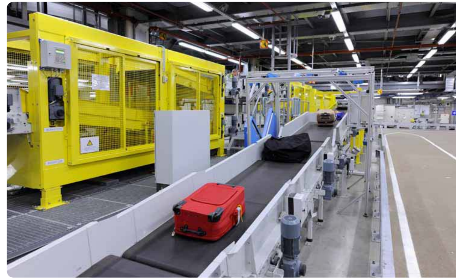
In totaal ligt er in de bagagekelders 21 kilometer aan transportband en 5 kilometer railsysteem. Schiphol heeft het modernste bagagesysteem ter wereld.
