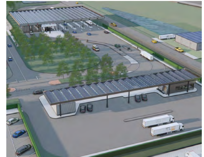
Doorlaatpost 90 heeft een demonteerbaar ontwerp, wat betekent dat materialen in toekomstige bouwprojecten kunnen worden hergebruikt.
